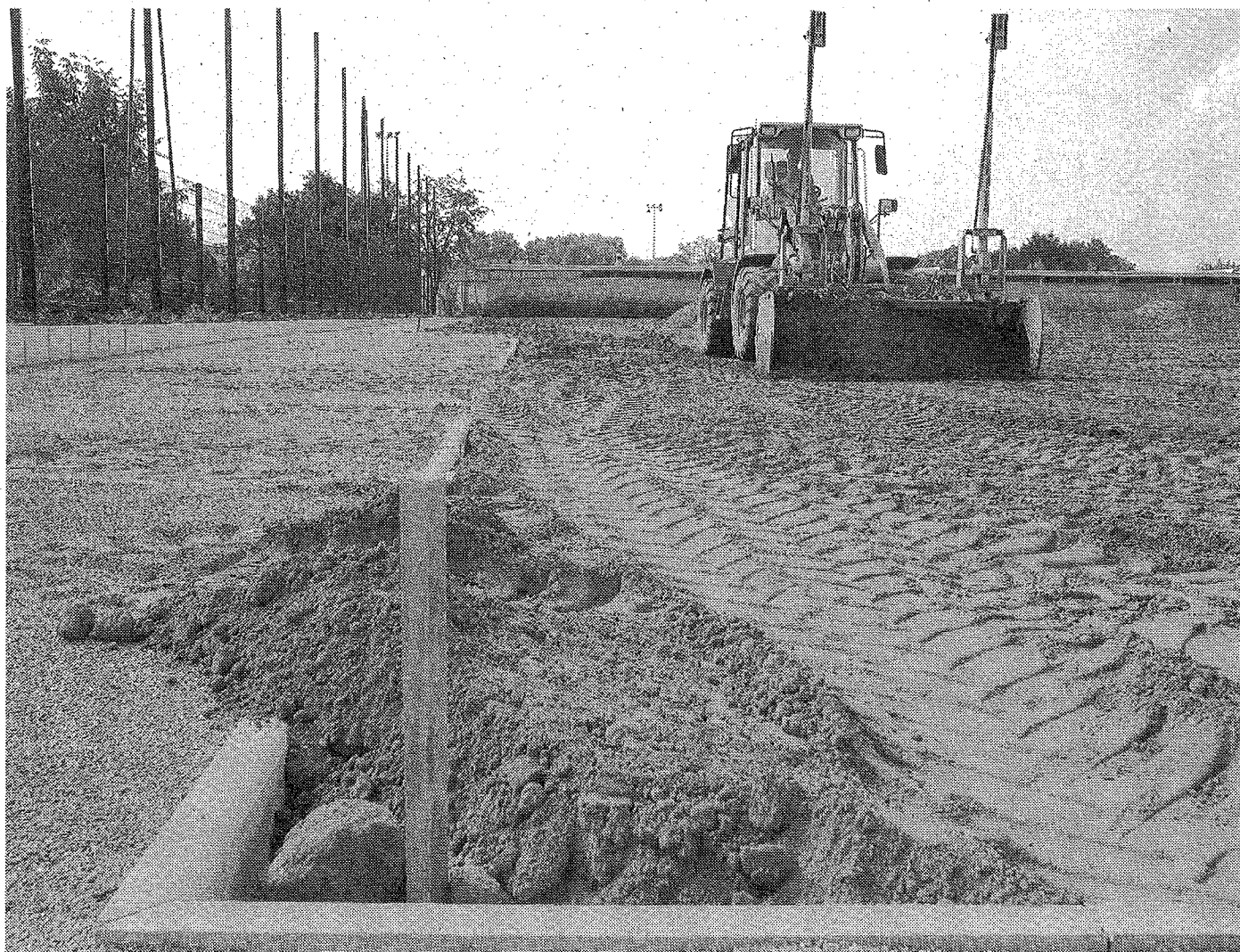
Le nivellement se terminera en fin de semaine. (Photo DNA—Laurent Réa)
